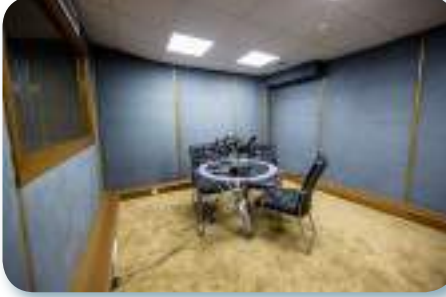
تستعمل ألواح ماصة للصوت في المسارح والاستديوهات
